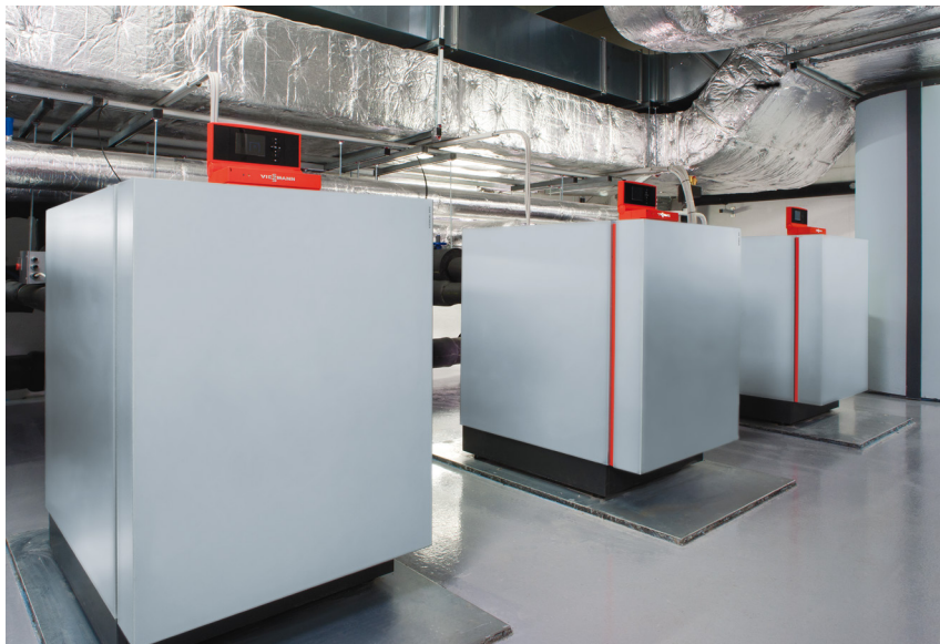
Zeme/ūdens siltumsūkņi Vitocal 300-G Apkures jauda ar vienu pakāpi: 21,2 līdz 42,8 kW, ar divām pakāpēm: 42,4 līdz 85,6 kW, maksimāli 428 kW (kā kaskāde)
