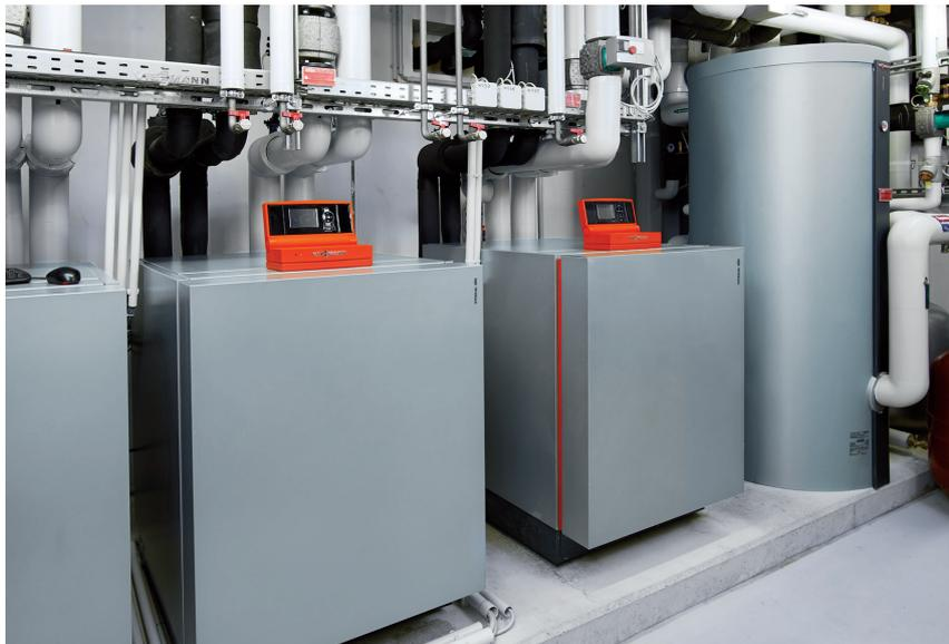
Sole/Wasser-Wärmepumpe Vitocal 350-G
